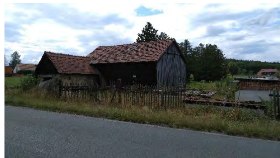
Abb. 4: Scheune mit Keller etwa mittig im Plangebiet
