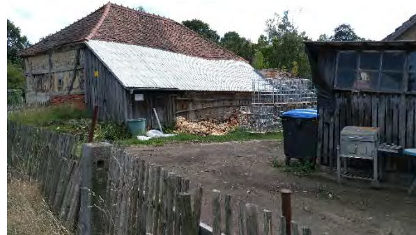
Abb. 11: Bebauung im Plangebiet
