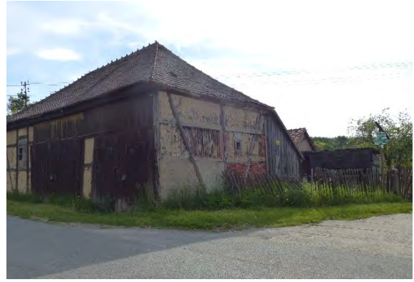
Abb. 2: Scheune Ecke Wilschdorfer Straße / Plattenweg
